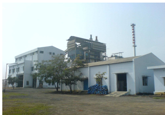
L'usine de production d'électricité
